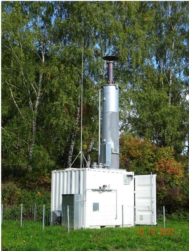
Die Inbetriebnahme der Schwachgasfackel erfolgte in der 3. Kalenderwoche 2022. Bei einer möglichen Betriebszeit von ca. 8.400 Bh (Betrieb ab KW 3 in 2022) erreichte die Schwachgasfackelanlage 7.956 Bh. Somit konnte eine effektive Betriebszeit von ca. 95% erreicht werden. Im Vergleich zur Altanlage konnte die Betriebszeit deutlich um das Drei- bis Vierfache erhöht werden.
